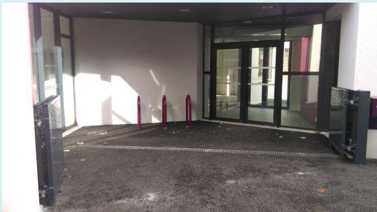
<<< Entrée principale du « Kiosque » avec vue sur cour et portail accordéon permettant ouverture totale sur cheminement ou assure un complément de protection lorsque la Maison des services est fermée (conception ICSAS, réalisation : entreprise SEEG)
