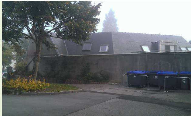
Nov. 2014: Terrain mitoyen avant travaux
