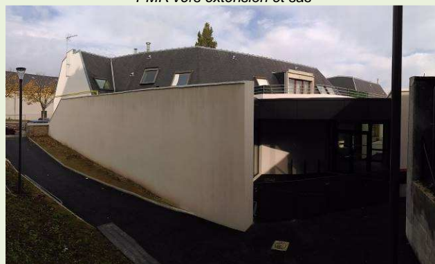
Nov. 2016 : Ouverture d'une brèche et création d'un cheminement PMR vers extension et sas
